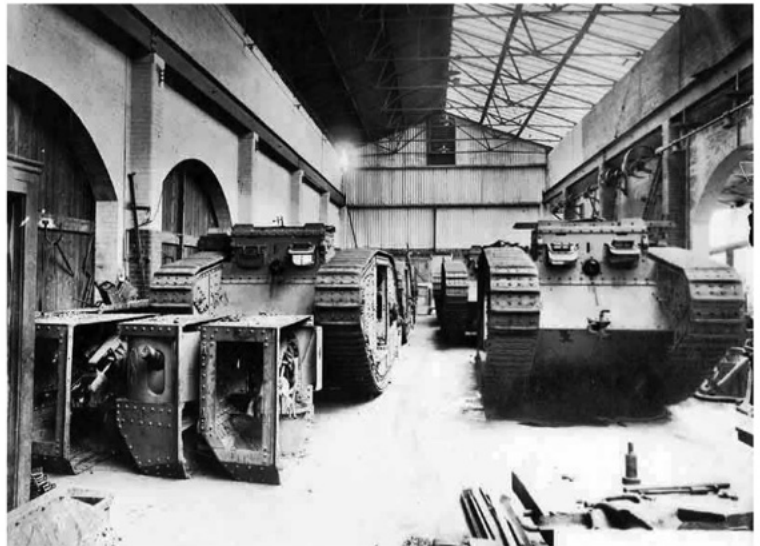
Het in Glasgow gevestigde bedrijf Hurst Nelson bouwde Mark IV rompen die vervolgens bij andere in het gebied van de Clyde gevestigde bedrijven verder werden bewerkt. De rij gaten aan de onderkant zijn voor de onderste rupsbandrollers, in de rechthoekige openingen aan de voorkant komen de spanschroeven voor de rupsbanden. Halverwege de romp en helemaal aan het eind zie je de staven waarmee het geheel wordt uitgelijnd.
